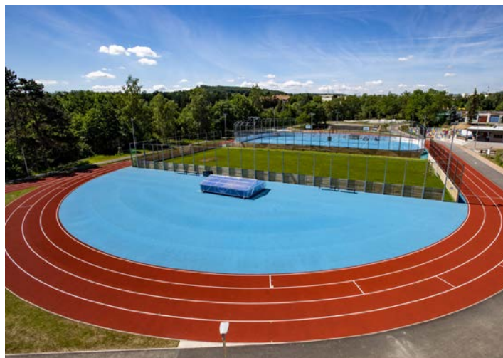
Vybudovali jsme sportovní areál u školy Nad Parkem
