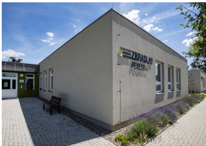
Zrekonstruovali jsme objekt na Žabovřeské ulici na Kulturně komunitní centrum Zbraslav
